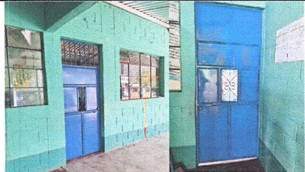
Foto 4: Pintura nueva de las puertas
