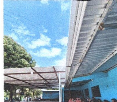
Foto 6: Instalacion de canaletas de pvc para aguas pluviales
