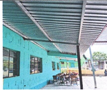
Foto 2: Laminas y costaneras galvanizadas nuevas
