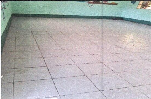
Foto 3: arreglo de piso en un aula
